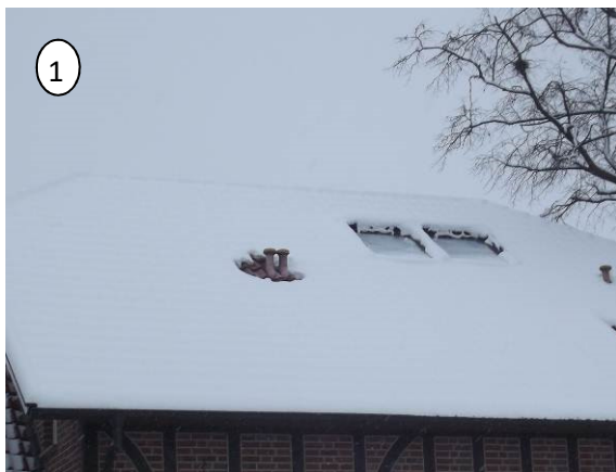
Intakt abgedichtetes gedämmtes Dach
